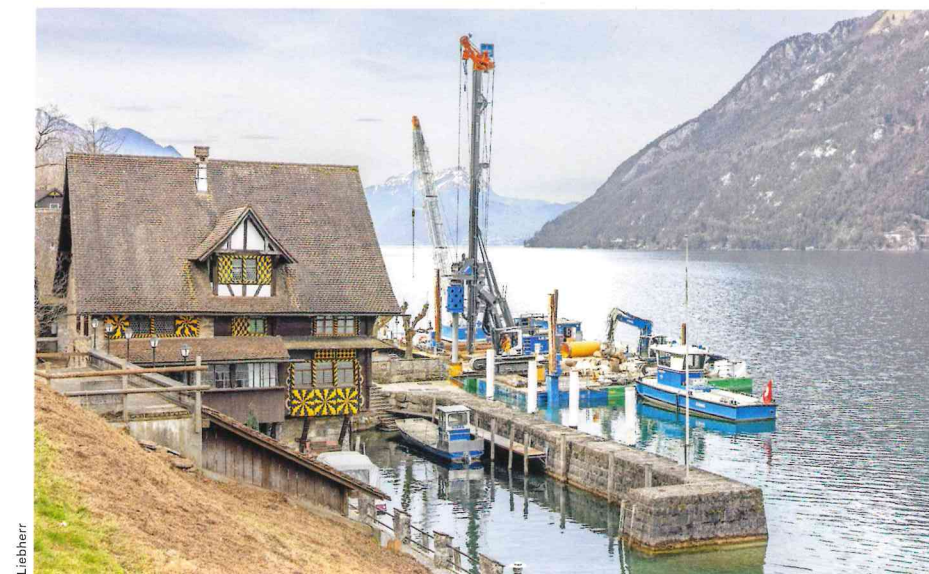
Um das Bohrgerät auf die Baustelle zu bringen, ist das Team von Kibag mit dem Ponton rund sechs Stunden über den See gefahren.
